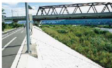
台風災害で越水した塩崎地区の堤防修復嵩上げ完了
